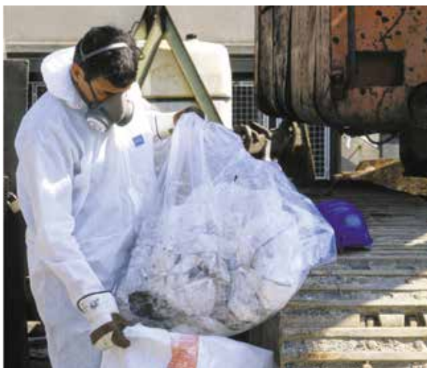
Les opérations de désamiantage nécessitent des protections adéquates.
