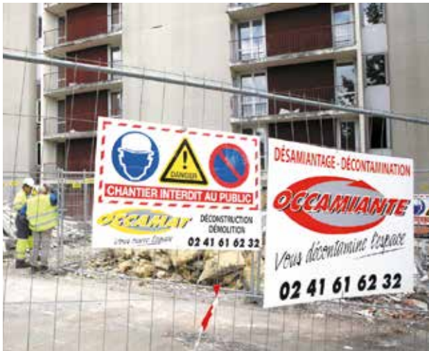
Le traitement de bâtiments amiantés doit être étroitement contrôlé.
