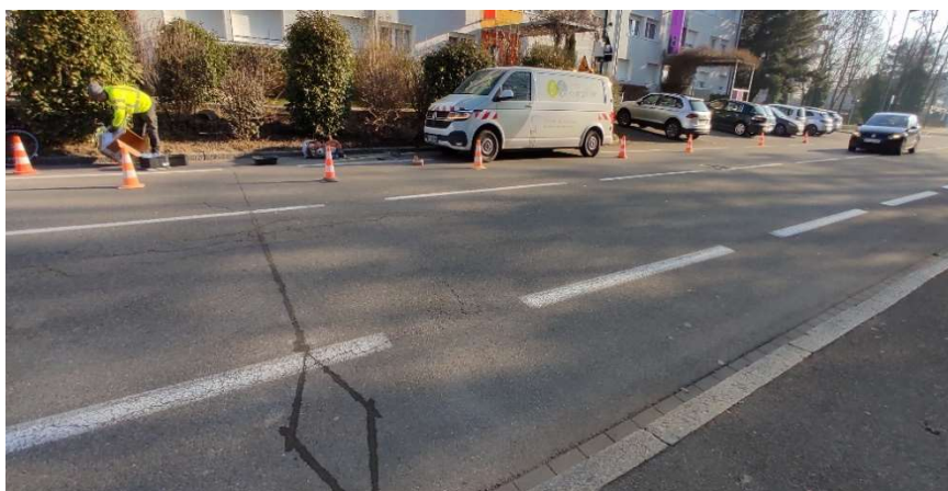
Travaux installation compteur vélos avenue de la Marne
