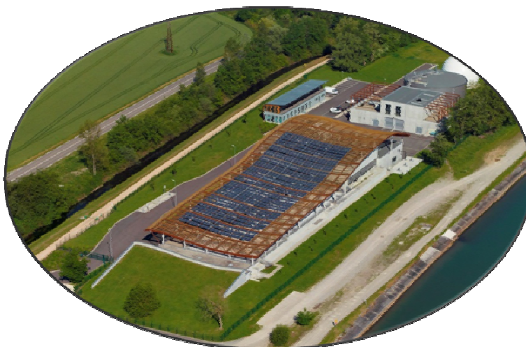
Station d'épuration à VILLAGE-NEUF
