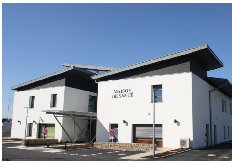
Maison de Santé à Folgensbourg
