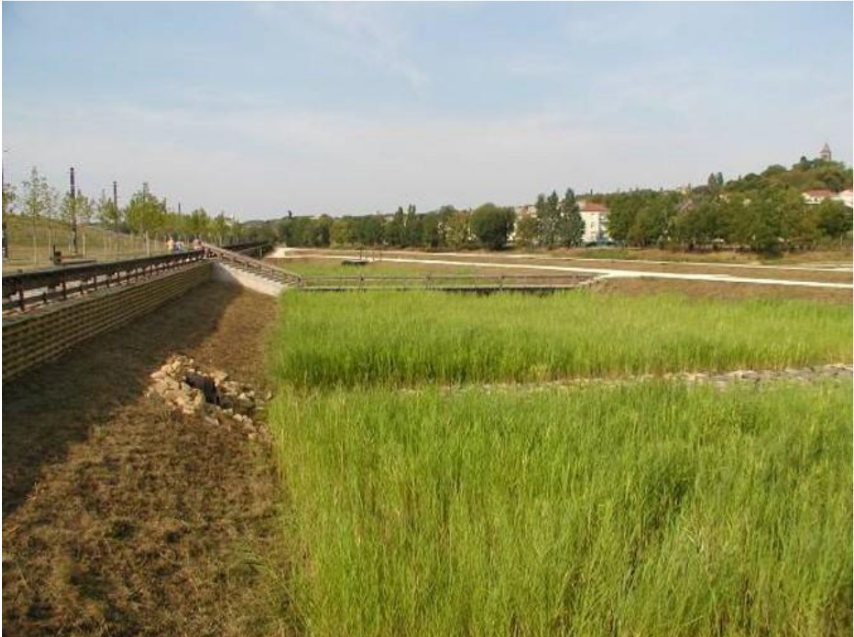
Photographie de référence d'un filtre planté de roseaux
