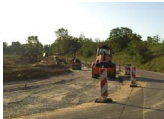
Démarrage des travaux de la ZAC du Technoparc - sept. 2019
