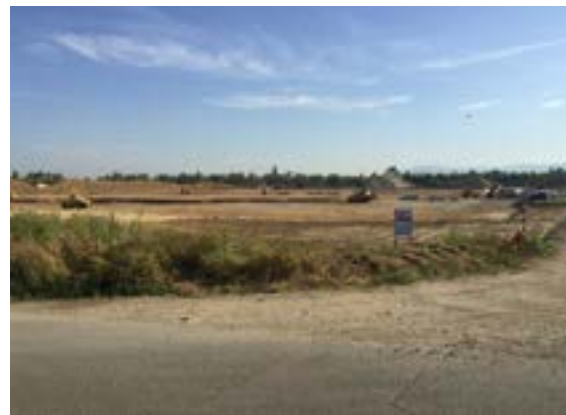
Démarrage des travaux du lot 1 STERLING - juillet 2019
