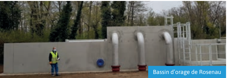
Bassin d'orage de Rosenau
