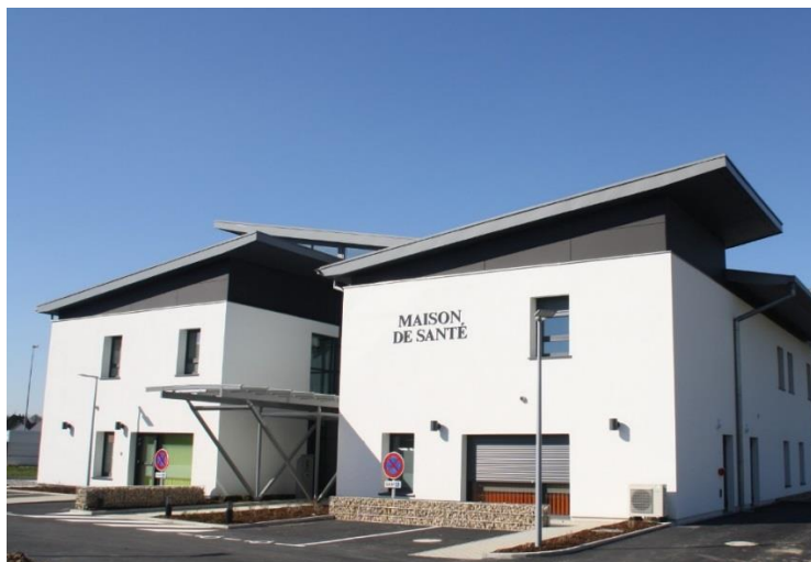
Maison de Santé à Folgensbourg
