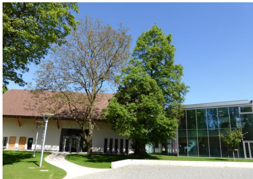
Médiathèque La Citadelle à Sierentz
