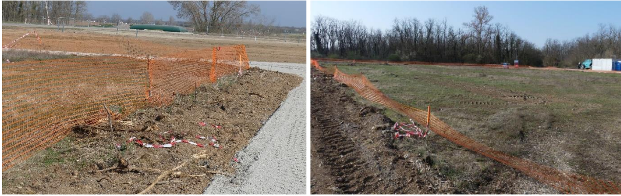
Figure 92 : Exemple de balisage orange de chantier – BEE ING, 2022
