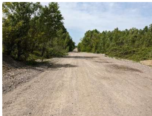
Figure 3 : chemin existant remobilisé pour la nouvelle voie - SERUE Ingénierie – Avril 2024
