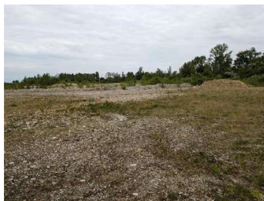
Figure 5 : Partie centrale amenée à être remblayée - SERUE Ingénierie – Avril 2024
